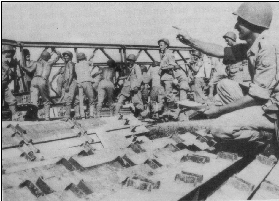
Construção da Ponte Bailey pela 1ª Cia do 9º BECmb. À direita, o Cmt Cap Floriano Möller (Fonte: Meira Mattos, 1983, p. 132).
